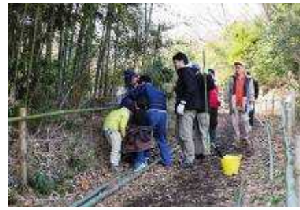
どうぶち 胴縁（横柵）を 取り付けた
