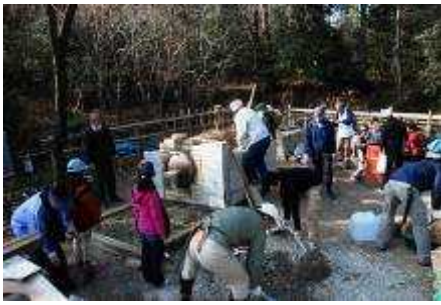
炭焼き窯の改修工事
