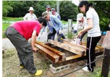
中の田んぼ前のベンチを更新、防腐塗装
