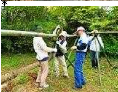
中の田の畦で「はざ」を設置中
