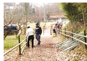
炭焼き広場以南の竹道の柵更新 ↑ 柵の胴縁取付け中
